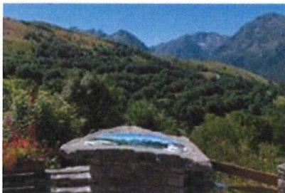
Support réalisé en pierres maçonnées (parement sur moellons) pour prendre l'aspect d'un muret, afin de respecter l'identité paysagère du site.
