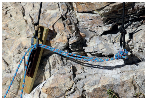
I LACCI, FISSATI ALLA ROCCIA, SONO COLLEGATI ALL'INNESCO DA UN MOSCHETTONE.
