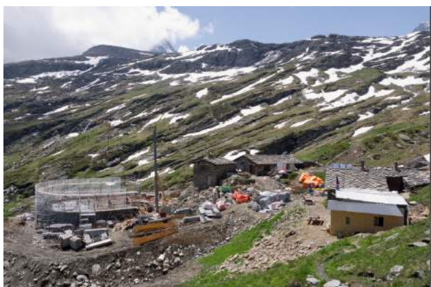
Construction du nouveau refuge 25 juin 2013
